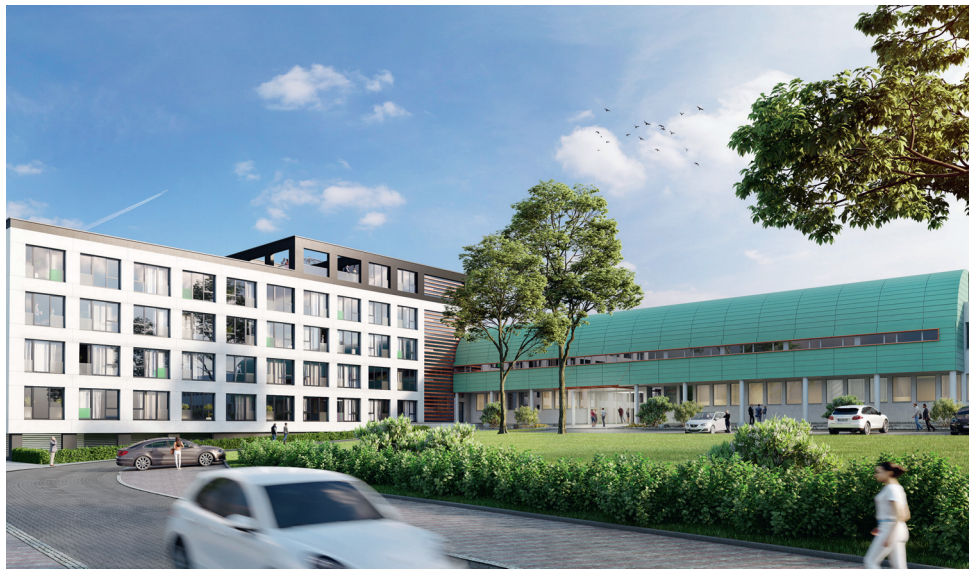
Zehn Millionen Euro an gepoolten Mitteln fließen in den Erweiterungsbau (linker Gebäudeteil) für die Vitos Orthopädische Klinik Kassel, der voraussichtlich im Frühjahr 2021 fertiggestellt wird. Das Projekt war vom Land Hessen auf absehbare Zeit nicht für eine Einzelförderung vorgesehen. Rendering: Kirschner & Partner, Heringen/Werra
